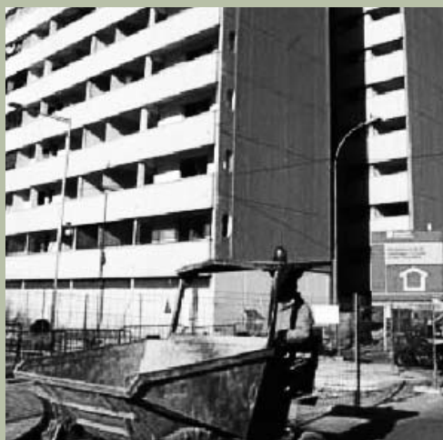
La Mina, un barri en ple procés de reforma destinat a millorar les condicions de vida dels seus habitants i a refer una imatge que es va deteriorar ben aviat després de la seva construcció fa quaranta anys.
